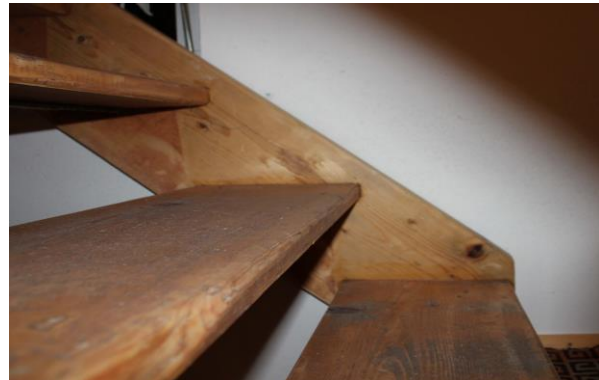
Treppe (mascil-Team Austria)
